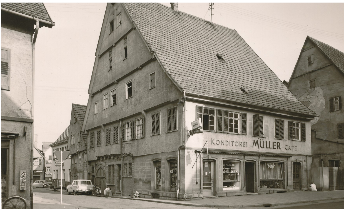
Der Altbau kurz vor seinem Abbruch 1961
